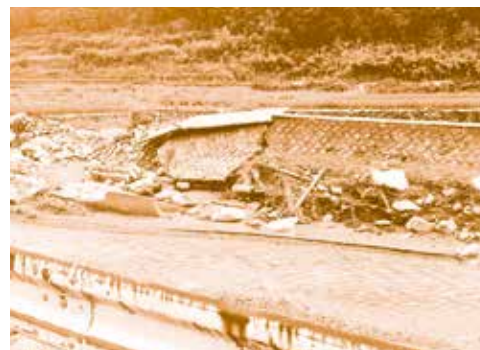
豪雨により被害を受けた河川
