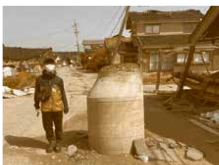
マンホールが、液状化により 170 cm近く上昇している 〔石川県珠洲市内〕
